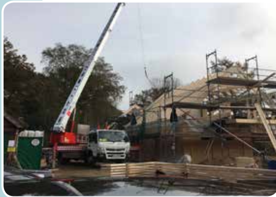
Neues Gemeinschaftshaus - der Dachstuhl wird gerichtet
